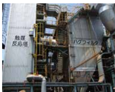
番の州エコサービス：焼却炉
